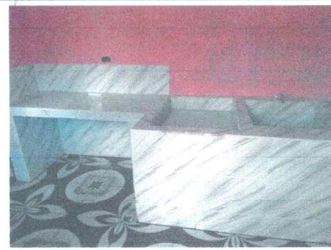
Foto 6: Suministro de piso cerámico
