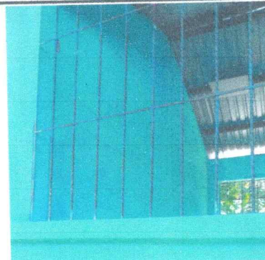
Foto 8: Mantenimiento de balcon
