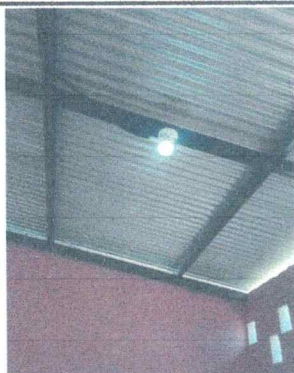
Foto 3: Sustitución de estructura de metal por metal
