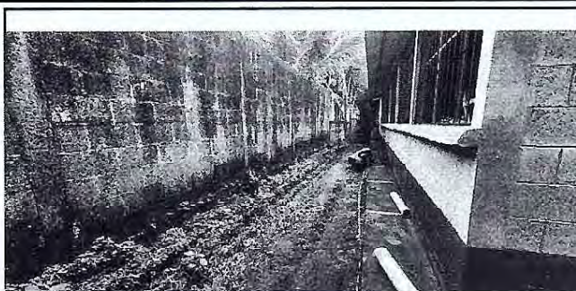
Foto 2: MURO PERIMETRAL Y MODULO DE AULAS
