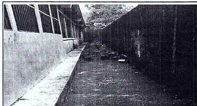
Foto 3: MURO PERIMETRAL Y MODULO DE AULAS
