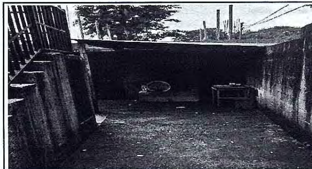
Foto 4: INGRESO AREA DE COCINA
