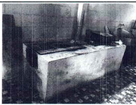
Foto 6: Se observa el mal estado de la estufa rural, presenta rajaduras en el área de la chimenea y las planchas están muy deterioradas.
