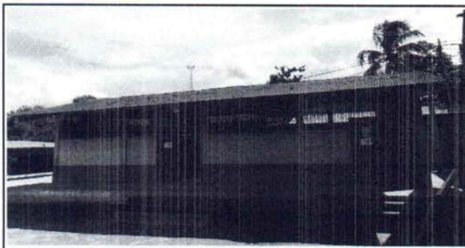
Foto 3: Se observa que es necesario cambiar la lámina del módulo de aulas, ya que se observa el deterioro de la misma.
