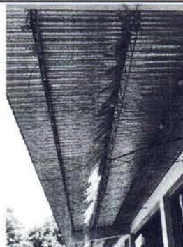
Foto 2: Se observa que la estructura de soporte se encuentra deteriorada, por lo que es necesario darle mantenimiento para prevenir su deterioro.
