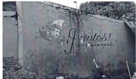
Foto 4: Se observa el muro perimetral que colinda con la carretera cito zarco muy deteriorada y por la parte de adentro de la escuela.
