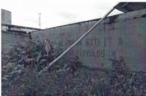
Foto 3: Se observa el muro perimetral de la parte de trasera que da a la carretera cito zarco que esta detenida con tierra y unos postes.
