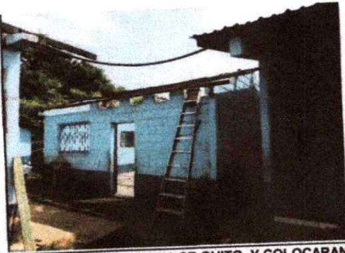
Foto 1: SE OBSERVA QUE LA LAMINA SE QUITO Y COLOCARAN LAS LAMINAS TROQUELADAS ALUZINC CALIBRE 26
