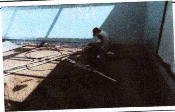
Foto 3: SE OBSERVA QUE EL SISTEMA ELECTRICO SE ESTACOLOCANDO CON SUS RESPECTIVOS ACCESORIOS.
