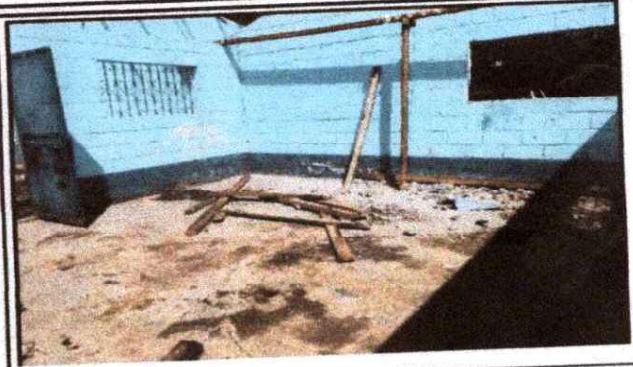
Foto 2: SE OBSERVA QUE LA ESTRUCTURA DE MADERA FUE QUITADA Y COLOCARAN LA ESTRUCTURA METALICA Y TUBO CUADRADO..
