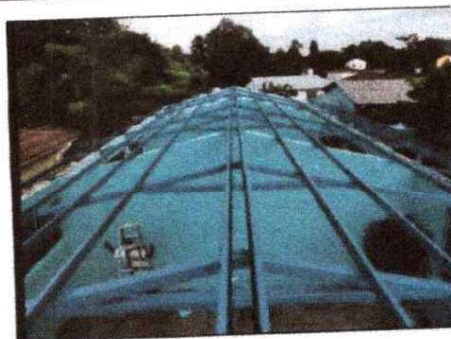
Foto 8: SE OBSERVA QUE LAS COSTANERAS SE LES ESTA DANDO MANTENIMIENTO REQUERIDO
