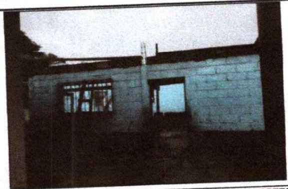
FOTO 4 : SE OBSERVA LA ELEVACION DEL MURO DE CONCRETO , SE ESTA REALIZANDO LOS TRABAJOS.
