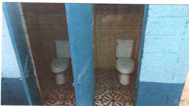
FOTO 9: Se observa que los sanitarios fueron colocados y terminados los trabajos.
