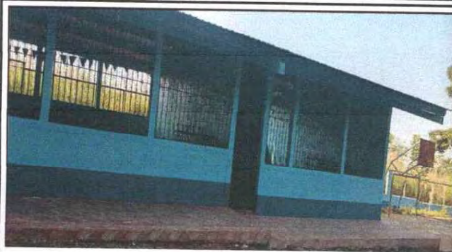
FOTO 8: Se observa que la aplicación de pintura interior y exterior, de modulo de aula se culmino el trabajo.
