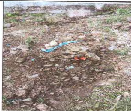
FOTO 10: Se observa que la tubería de aguas negras fueron colocados y terminados los trabajos.
