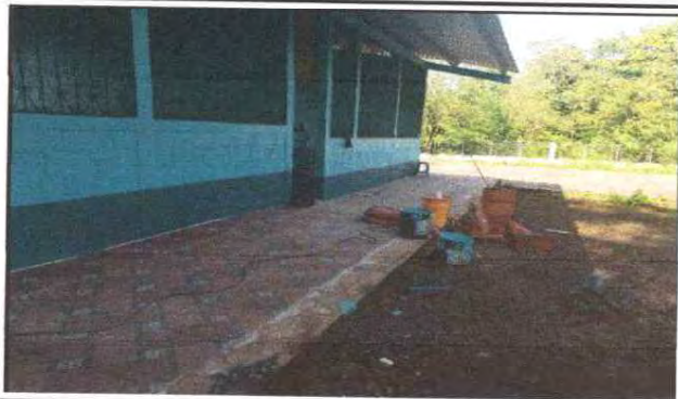
FOTO 7: Se observa que los trabajos de mantenimiento a balcon de aula y fueron terminados los trabajos.
