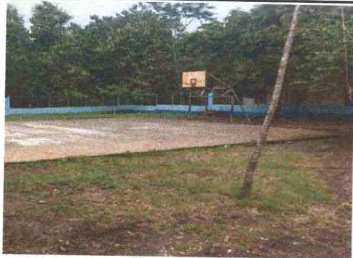
FOTO 13: Se observa que se aplico pintura en la pared de muro perimetral se concluyo el trabajo.
