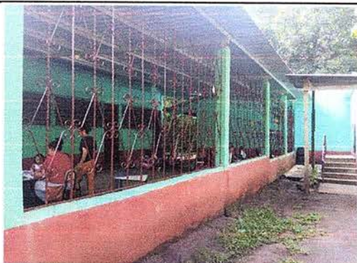
Foto 9: Se observa balcon de metal instalado.
