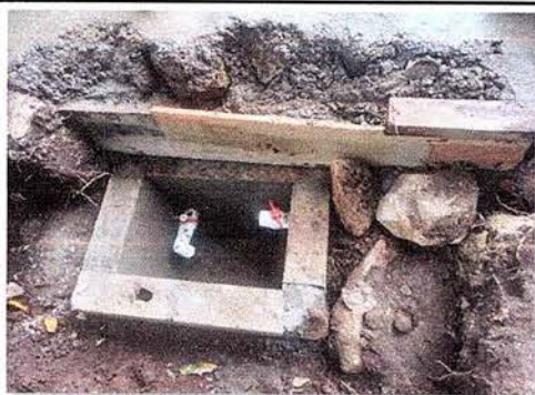
Se observa caja de registro de absorción instalado.
