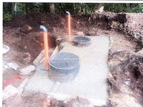
Foto 10: Se observa biodigestores y pozo de absorción instalados.
