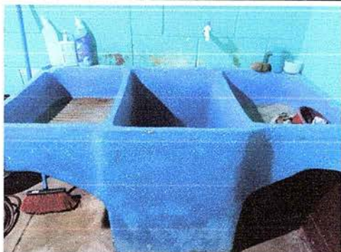
Foto 3: Se observa pila instalada.
