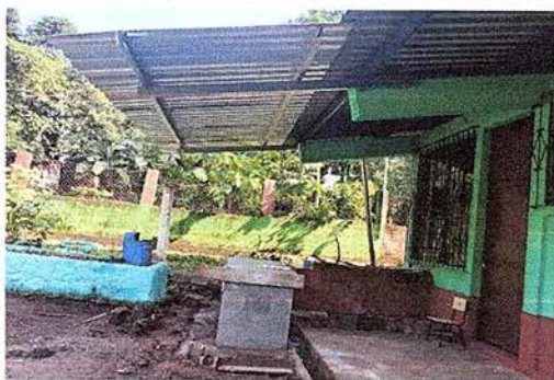
Foto 5: Se observa lámina y estructura de metal instalada.
