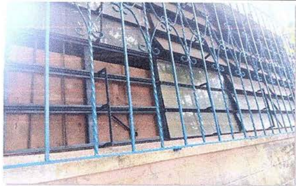
Foto 1: Se observa balcón de metal instalado.
