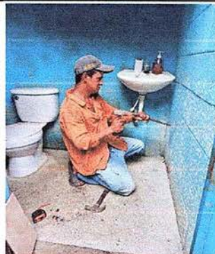
Foto 8: Se observa la colocación de piso cerámico, azulejo y la sustitución de accesorios en el lavamanos.
