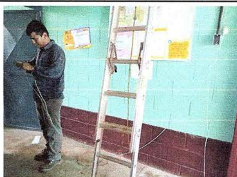
Foto 2: Se observa la reparación del sistema eléctrico.
