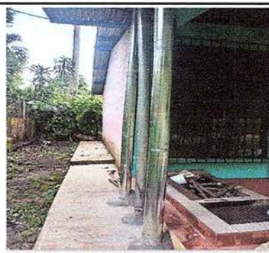
Foto 6: Se observa la sustitución de la chimenea.
