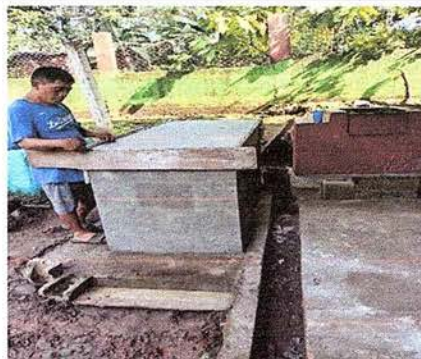
Foto 4: Se observa la conformación del mueble de cocina.
