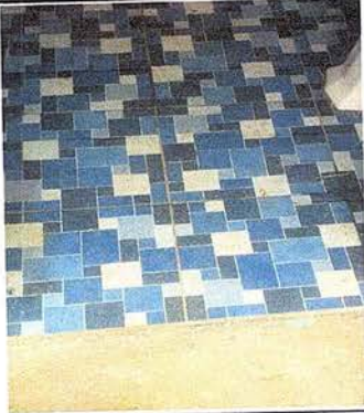
Foto 13: Se observa que el piso ceramico se esa colocando.
