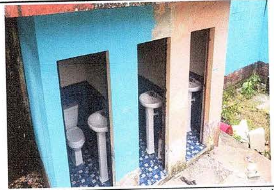
Foto 14: Se observan que los trabajos de aplicación de pintura interior y exterior se esta realizando.
