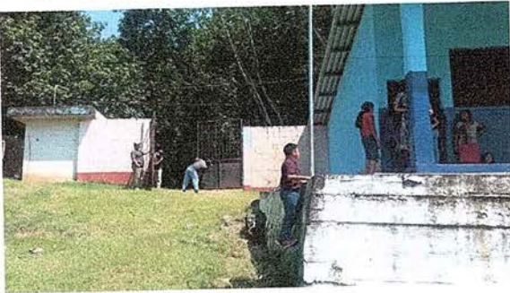
Foto 17: Se observa que el mantenimiento a porton se esta realizando.
