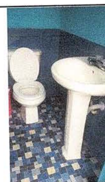
Foto 12: Se observa que los lavamanos se esta colocado.
