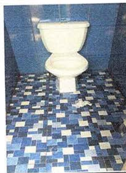
FOTO. 11: Se observa la colocacion de los inodoros
