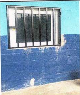
Foto 5: Se observa que las paredes se les aplicando la pintura interior y exterior
