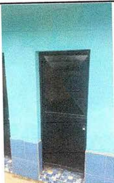
Foto 10: Se observa que la puerta de baño se esta cambiando .
