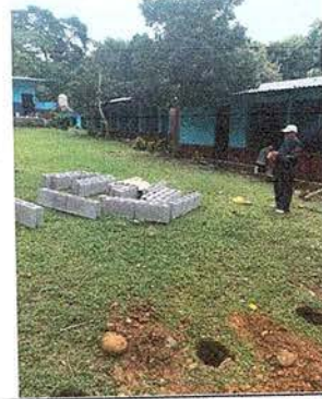
Foto 16: Se observa que los trabajos del muro perimetral se esta realizando.
