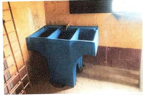
Foto 2: Se observa que la pila de cemento de dos lavaderos se esta colocando.
