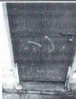
FOTO 10: Se observa que la pintura de las puerta de los baños se encuentra en mal estado, urge el cambio.
