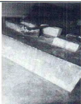
FOTO 1: Se observa que el polloton esta en mal estado, por lo que necesita sustitucion de carácter urgente.
