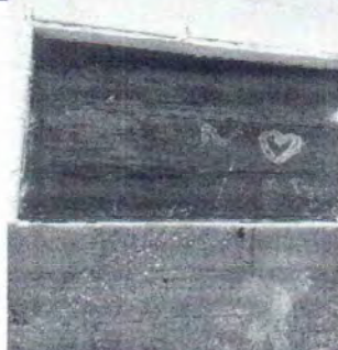
FOTO 4: Se observa que la ventana de la cocina necesita mantenimiento por deterioro de la pintura.
