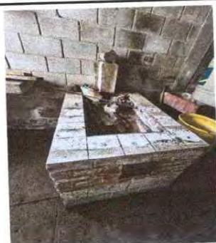
Foto 11: Se observa la falta de componentes en la estufa rural como: plancha de metal
