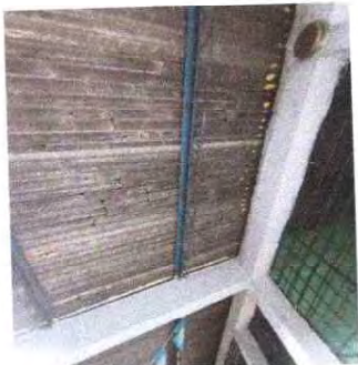
Foto 1: Se observa el mal estado de la lamina que causa goteras
