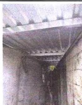
Foto 12: Se observa que se realizó la instalación de la lamina.
