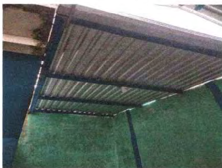
Foto 15: Se observa que se realizó la instalación de la lamina.
