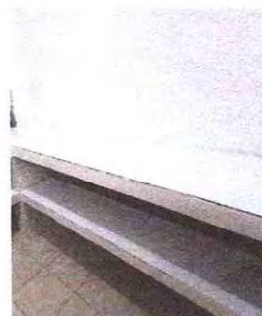
Foto 6: Se observa que se realizó el repello de la pared.
