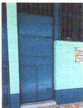
Foto 9: Se observa que se realizó la conformación de la puerta
