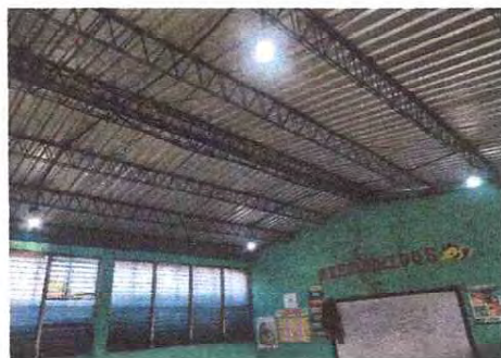
Foto 3: Se observa que se realizó la reparación del sistema eléctrico.
