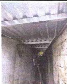
Foto 11: Se observa que se realizó la instalacion de la estructura
