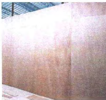
Foto 10: Se observa que se instalo el entrepaño
