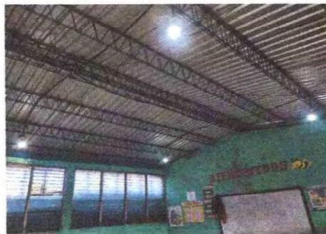
Foto 2: Se observa que se realizó el mantenimiento a la estructura.
