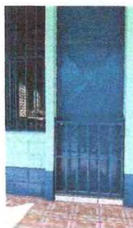
Foto 5: Se observa que se realizó la sustitución de la chapa.
