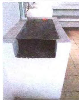
Foto 4: Se realizó la sustitución de la estufa.
