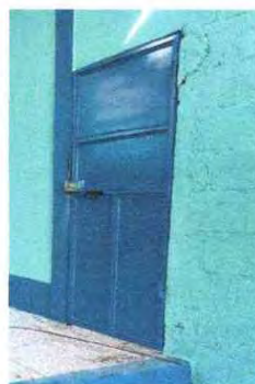
Foto 16: Se observa que se realizó la sustitución de la puerta.
