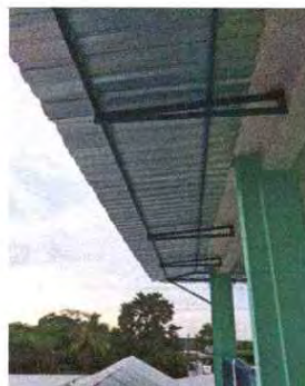
Foto 14: Se observa que se realizó la instalacion de la estructura
