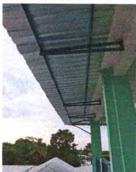
Foto 13: Se observa que se realizó la instalación de la lamina.
