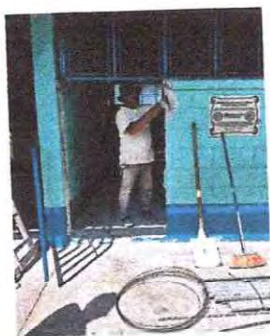
Foto 9: Se procede a la conformación de la puerta
