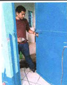
Foto 5: Se procede a realizar la sustitución de la chapa.
