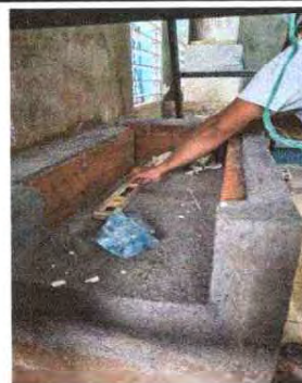
Foto 4: Se procede a realizar la sustitución de la estufa
