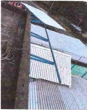
Foto 13: Se procede a la instalación de la lámina.
