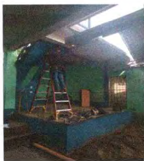
Foto 3: Se procede arreglar el sistema electrico.
