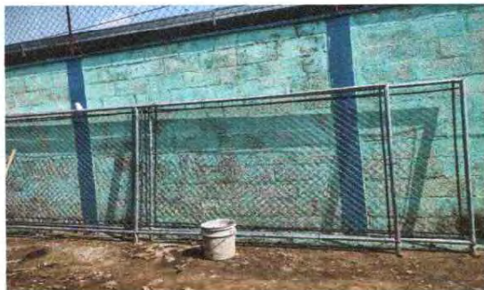
Foto 1: Se procede a reparar la cerca perimetral.
