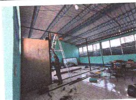
Foto 10: Se procede a la instalación de entrepaño
