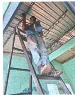
Foto 2: Se procede a brindar mantenimiento a la estructura.
