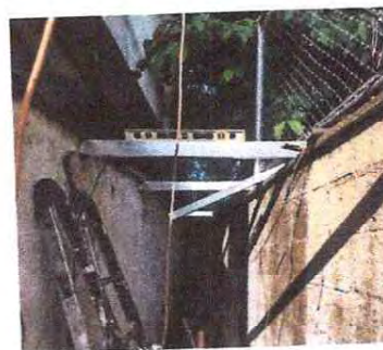
Foto 12: Se procede a la instalación de la lamina
