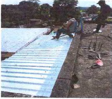
Foto 15: Se procede a la instalación de la lámina.
