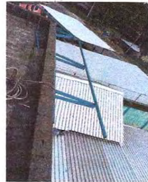
Foto 14: Se procede a instalar la estructura de soporte
