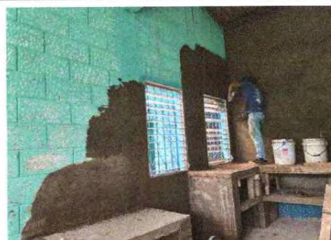
Foto 6: Se procede a repellar las paredes.
