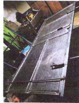
Foto 16: Se procede a la sustitución de la puerta.
