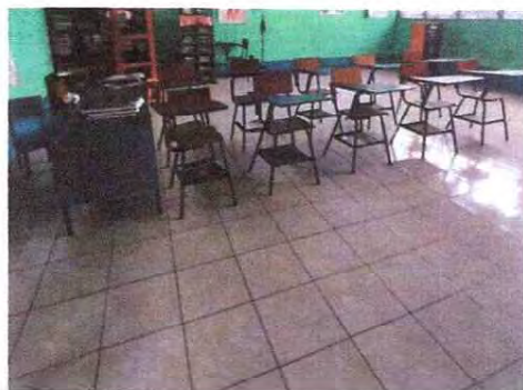
Foto 9: en esta parte se conformara la puerta para aperturar el ingreso de la division del salon.
