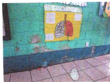
Foto 6: se observa falta de repello en las paredes.
