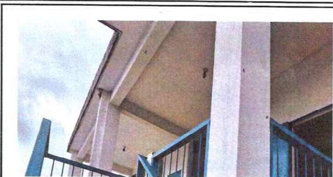
Foto 14: en esta parte del módulo, es donde se colocara la viceria con la lamina por lo que requiere tambien estructura.
