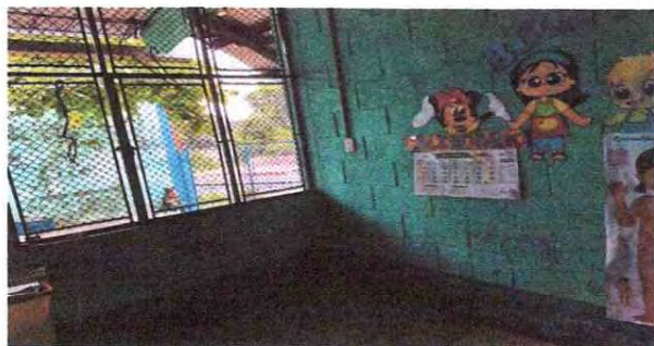
Foto 7: se observa el area donde ira el banco de trabajo.
