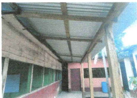
Foto 3: Se observa que la estructura de soporte de madera fueron sustituidos.
