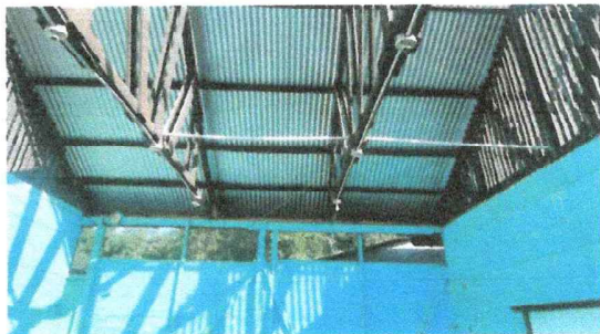
Foto 1: Se observan que la estructura soporte de madera se le brindo mantenimiento.
