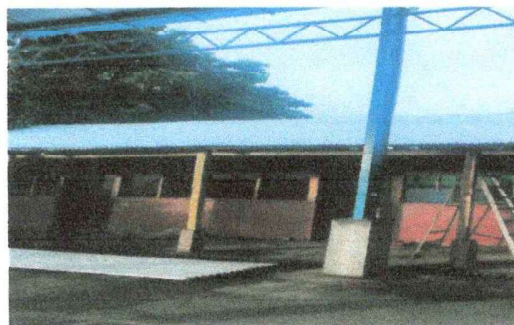
Foto 2: Se observa que las laminas fueron sustituidas
