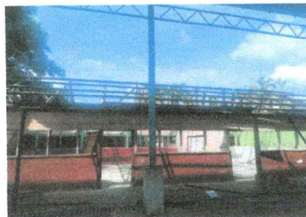
Foto 2: Se procede a quitar las laminas para su sustitución
