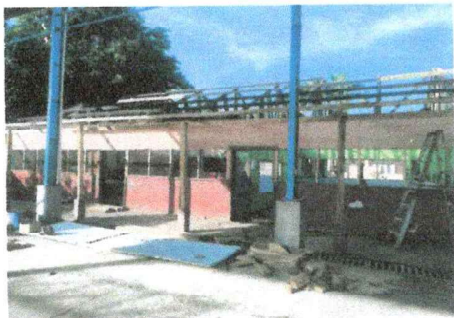
Foto 1: Se procede a darle mantenimiento a la estructura
