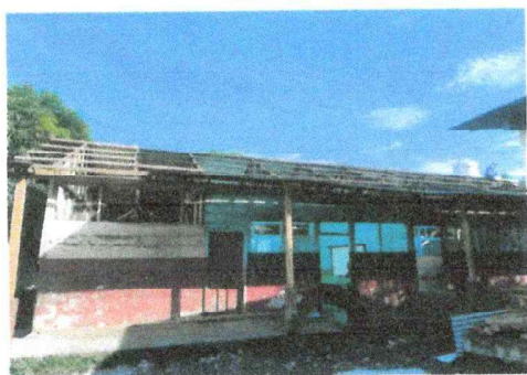
Foto 3: Se procede a quitar la estructura del pasillo para poder cambiarlo.
