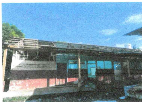
Foto 4: Se procede a cambiar el techo del pasillo
