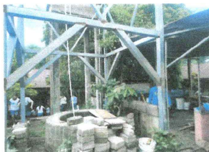
Foto 6: Se procede a realizar el muro de block
