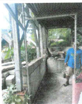
Foto 5: Se procede a colocar la puerta de la cocina
