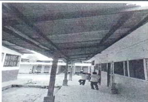
Foto 3: Se observa que la estructura de soporte de madera del pasillo esta muy deteriorada
