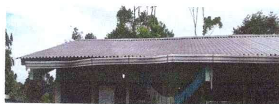
Foto 6: Se observa que los canales para la bajada de agua se encuentran en mal estado por lo que requiere sustitución.
