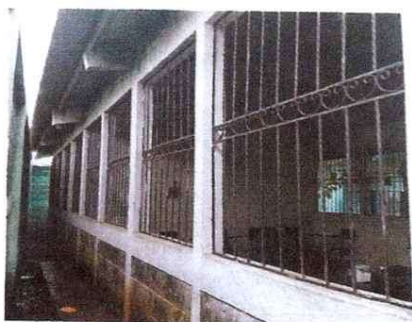
Foto 5: Se observa la pintura deteriorada de los balcones por lo cual requiere mantenimiento.
