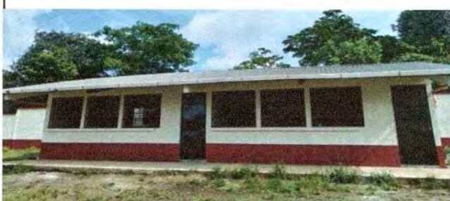
Foto 9: se observa que se realizó el resane del módulo.
