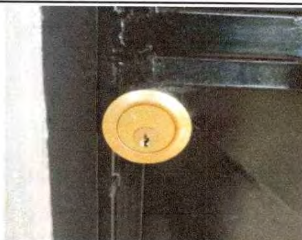
Foto 14: se observa que se realizó el cambio de la chapa
