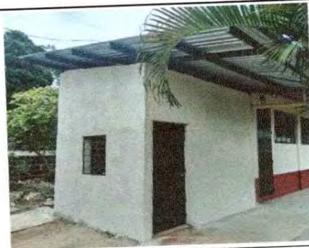
Foto 4: se observa que se realizó el repello de la pared.
