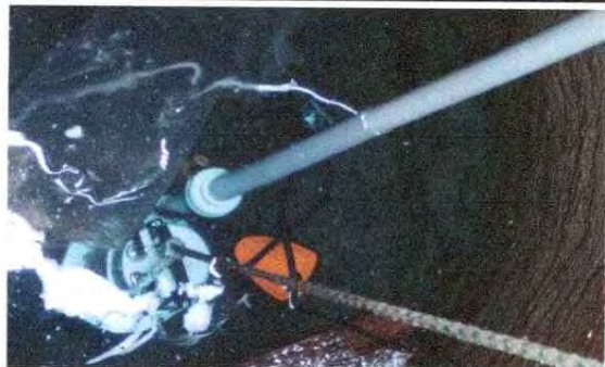
Foto 13: se observa que se realizó la sustitución de la bomba.
