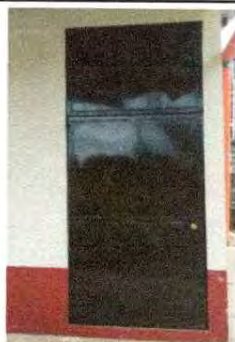
Foto 21: se observa que se realizó la sustitución de las puertas.
