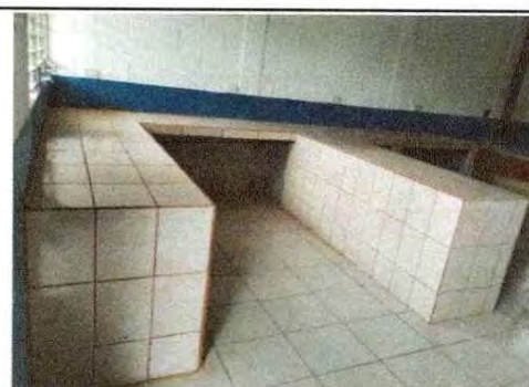
Foto 16: se observa que se instaló el azulejo en los muebles.
