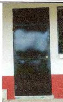
Foto 8: se observa que se realizó la sustitución de la puerta.
