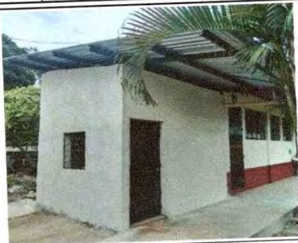
Foto 1: Se observa que se realizó la instalación de la lámina.
