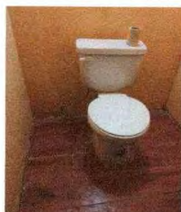
Foto 17: se observa que se realizó la instalación del baño.
