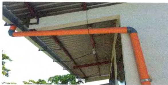
Foto 20: se observa que se realizó la sustitución de la tubería.
