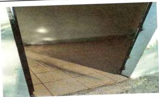
Foto 3: se observa que se realizó la instalación del piso.
