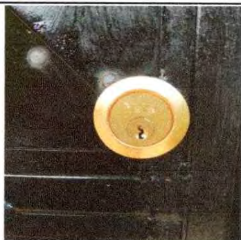
Foto 7: se observa que se realizó el cambio de la chapa
