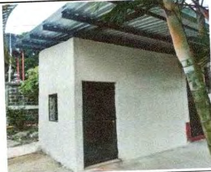
Foto 2: Se observa que se realizó la instalación de la estructura de soporte.
