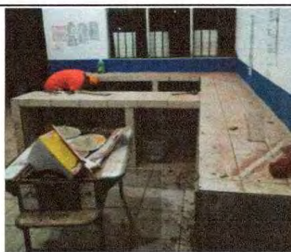
Foto 16: se observa que se realiza la sustitución del azulejo de los muebles de la cocina.
