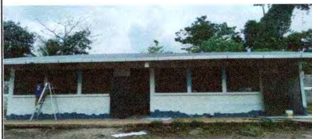
Foto 9: se observa que se realiza el trabajo de pintura en el modulo que ha sufrido deterioro en la misma.
