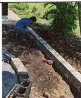
Foto 11: se observa que se realiza la reparación de la plancha del patio.
