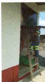
Foto 21: se observa que se empiezan a sustituir las puertas de los salones.
