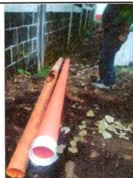
Foto 10: se observa que se realiza la sustitución de la tubería que transporta las aguas negras.
