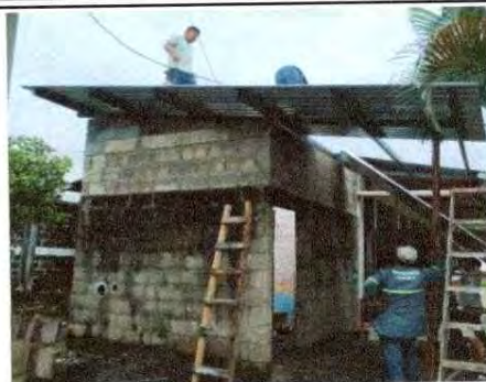
Foto 2: Se observa que se realiza la instalación de la estructura de soporte para poder colocar las láminas.
