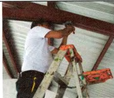
Foto 12: se observa que se realiza la sustitución del sistema eléctrico.
