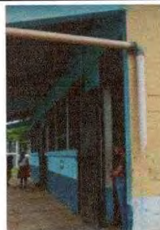
Foto 20: se observa que se empieza arreglar la tubería.
