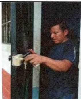
Foto 7: se observa que se realiza la sustitución de la chapa.
