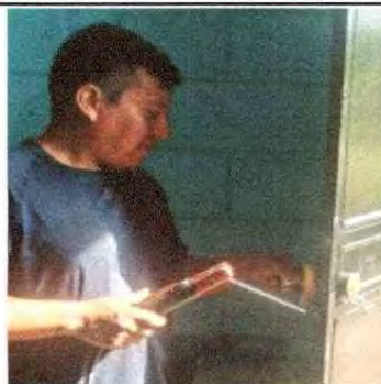
Foto 14: se observa que se realiza la sustitución de la chapa.
