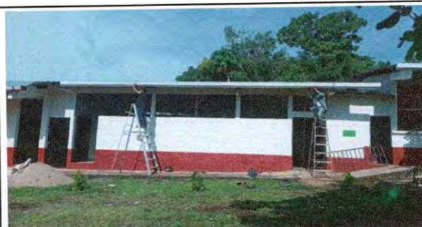
Foto 6: se observa que se instalan canales de bajada de agua en el modulo 1.
