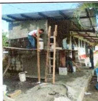
Foto 4: se observa que se realiza el repello en el modulo para que no se filtre el agua.
