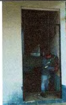
Foto 8: se observa que se realiza la sustitución de las puertas.
