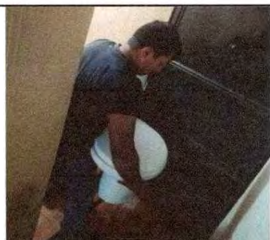
Foto 17: se observa que se realiza el cambio de el inodoro.
