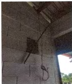
Foto 19: se observa que se empieza arreglar el sistema eléctrico.
