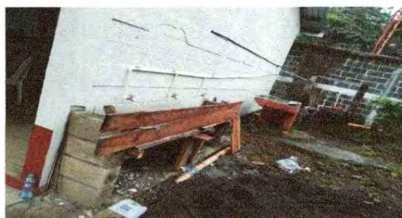
Foto 18: se observa a instalar la estación de lavado.
