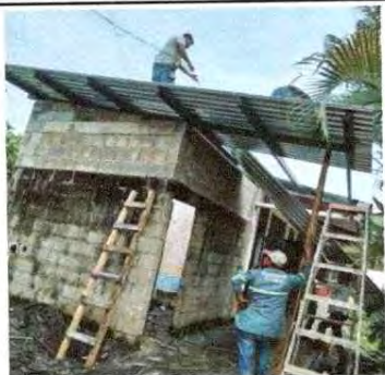
Foto 1: Se observa que realiza la instalación de la lámina.
