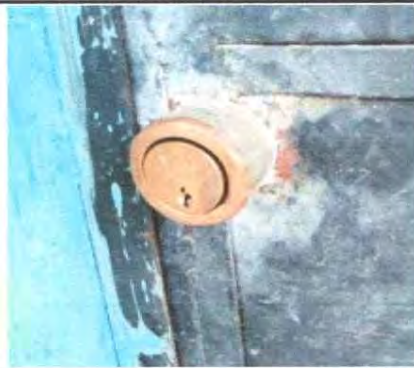
Foto 14: se observa que la chapa ya se encuentra dañada y ya no es segura.
