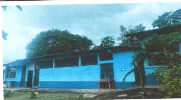
Foto 6: se observa que el modulo 1 de aulas no cuenta con canales de bajada de agua.
