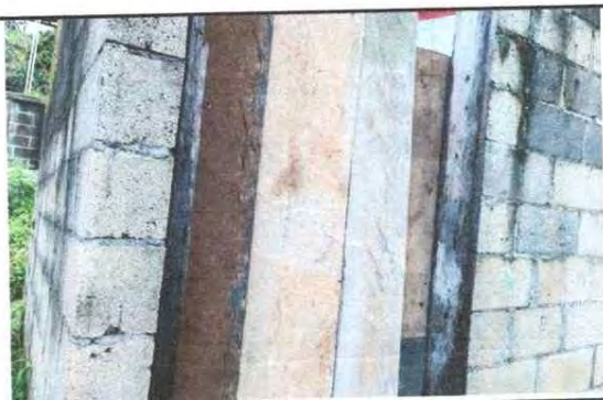
Foto 5: se observa que el salon que se usara para direccion no cuenta con puerta por lo que es importante colocarle una.
