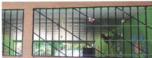
Foto 5: se procede a pintar los balcones de los modulos.
