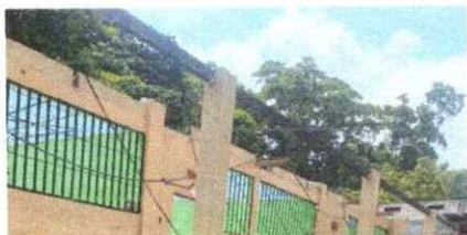
Foto 7: Se inicia a la sustitución de estructura de soporte.
