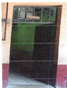
Foto 9: se inicia al cambio de las puertas de los baños de los varones.
