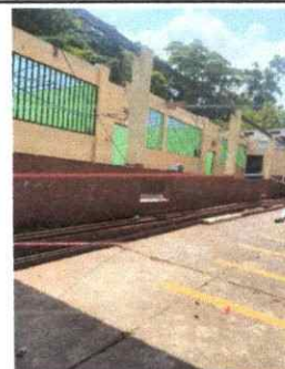
Foto 6: Se inicia a la sustitucion de las láminas.
