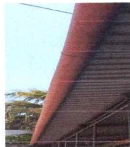
Foto 8: Se inicia al desmontaje del canal de bajada de agua para su sustitución.
