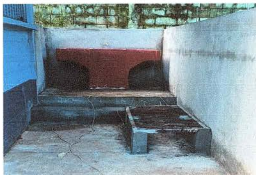
Foto 3: Se observa el polletón ya reparado
