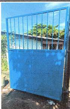
Foto 9: Se observa el segundo portón ya sustituido
