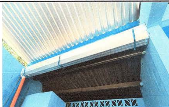
Foto 2: Se observa el suministro e instalación de canales de agua pluvial en área de pila
