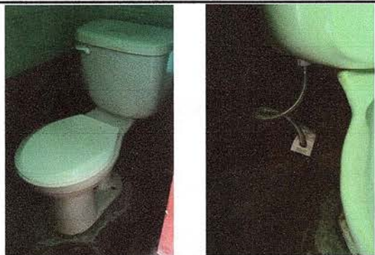
Foto 11: Se observan los servicios sanitarios ya reparados
