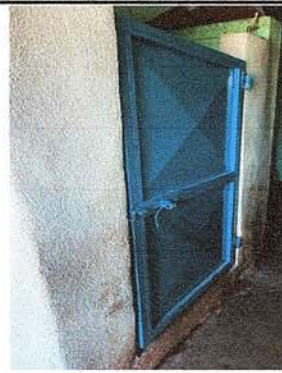
Foto 10: Se observan las puertas de los servicios sanitarios ya instaladas
