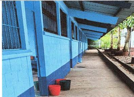
Foto 8: Se observan los muros exteriores e interiores con su respectivo mantenimiento
