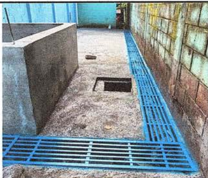
Foto 5: Se observa área lodosa completamente pavimentada y con sus respectiva cuneta + rejilla
