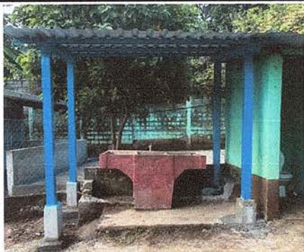
Foto 1: Se observa la sustitución de cubierta y estructura de metal, ya finalizada en el área de pilas
