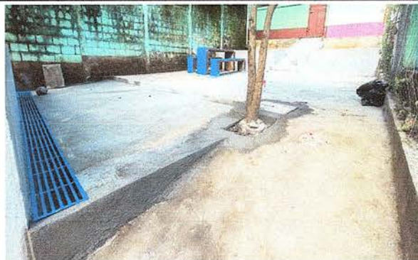
Foto 4: Se observan los trabajos finalizados en muro de protección, cuneta + rejilla y pavimento (empedrado fraguado)
