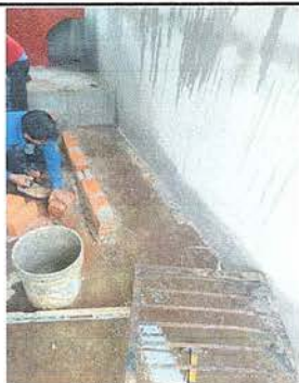
Foto 3: Se observa la reparación del polletón en proceso
