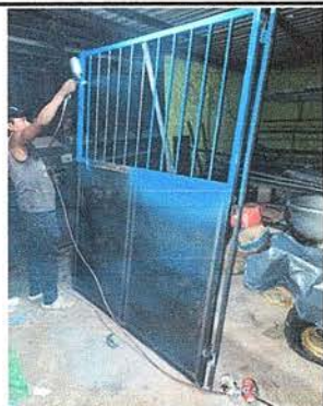
Foto 9: Se observa los trabajos previos a sustituir un segundo portón
