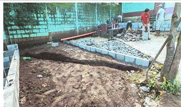
Foto 4: Se observan la ejecución de los trabajos de conformación de muro, cuneta y pavimento (empedrado fraguado)
