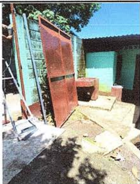
Foto 7: Se observan los trabajos de reparación del portón principal
