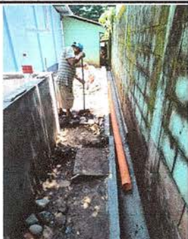
Foto 5: Se observa área en donde se está ejecutando el pavimento de empedrado fraguado
