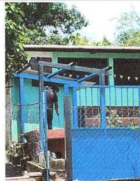
Foto 2: Se observa otra vista de los trabajos realizados en el área de pila
