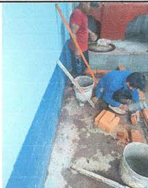
Foto 3: Se observa la reparación del polletón en proceso
