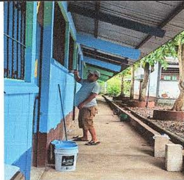
Foto 8: Se observa el proceso de aplicación de pintura en muros exteriores e interiores
