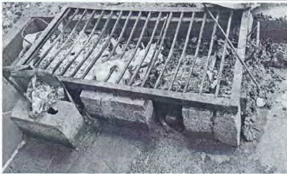
Foto 3: Se observa que el polietileno necesita reparación
