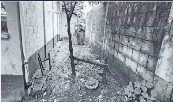
Foto 5: Se observa área con mucho lodo, es necesario suministrar pavimento de empedrado fraguado
