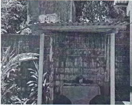
Foto 1: Se observa que la cubierta y estructura portante del área de pilas necesita sustitución
