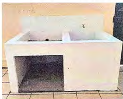
Foto 5: Pila de concreto con azulejos.
