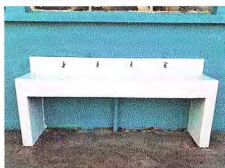
Foto 2: Estación de lavado para los niños.
