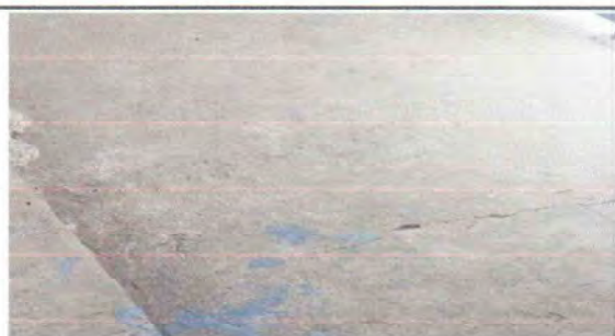
FOTO 6: Se observa que el piso esta en mal estado por lo que se necesita sustitucion por piso cerámico.
