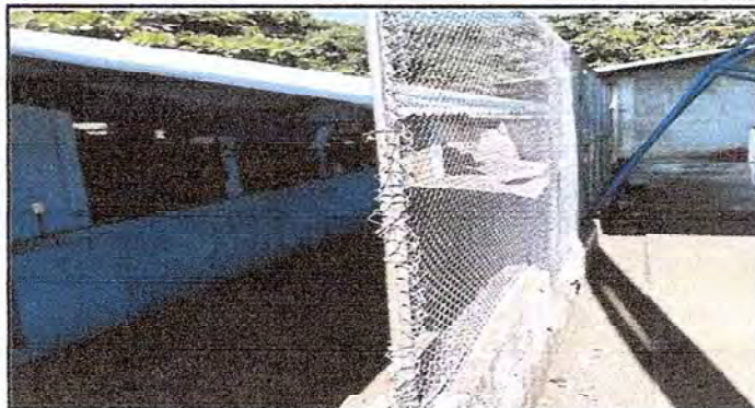
Foto 8: Se observa muro perimetral de malla cambiado
