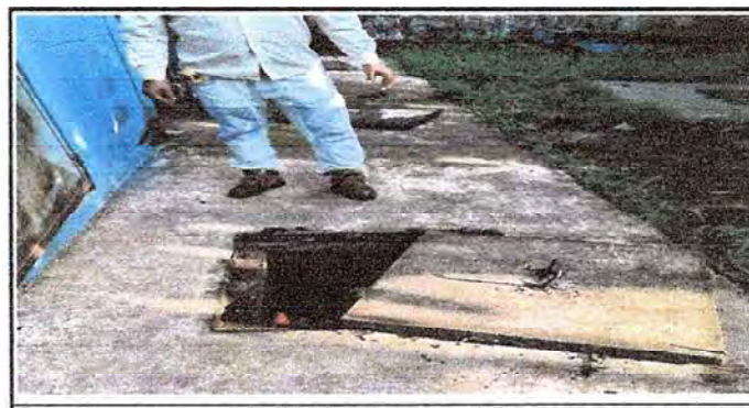
Foto 6: Se observa el trabajo de mantenimiento a las cajas de registro
