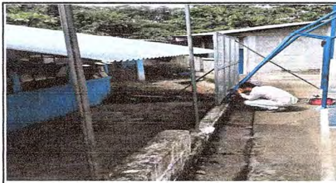
Foto 8: Se observa el trabajo en el muro perimetral de malla
