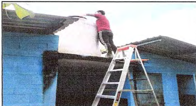
Foto 9: Se observa el trabajo en el depósito de agua
