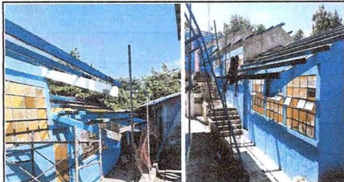
Foto 1: Se observa desmontaje de techo en mal estado
