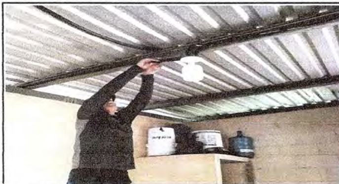
Foto7: Se observa el trabajo en el sistema eléctrico
