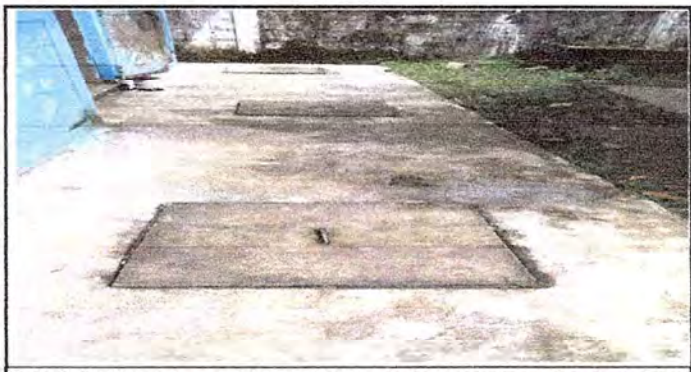
Foto 6: Se observa necesidad de dar mantenimiento a las cajas de registro
