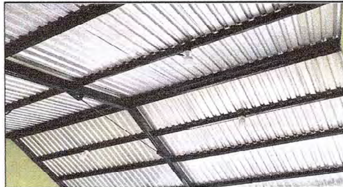
Foto 4: Se observa sistema eléctrico cambiado
