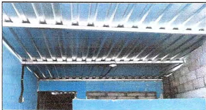
Foto 9: Se observa techo de lámina cambiado
