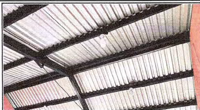
Foto 2: Se observa la estructura del techo remozada
