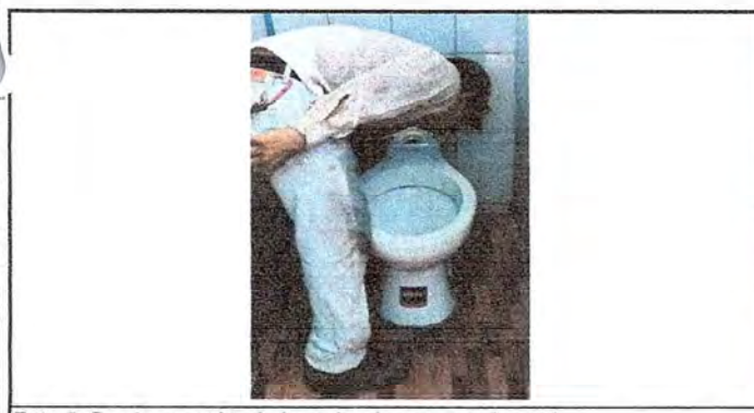
Foto 5: Se observa el trabajo en inodoros en mal estado
