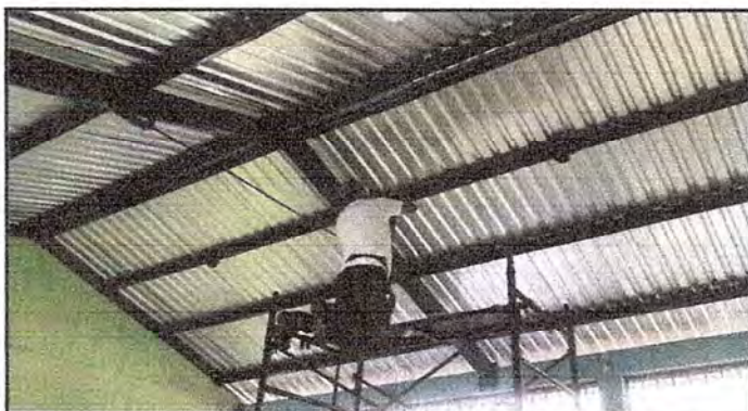
Foto 4: Se observa el trabajo en el cambio del sistema eléctrico en mal estado
