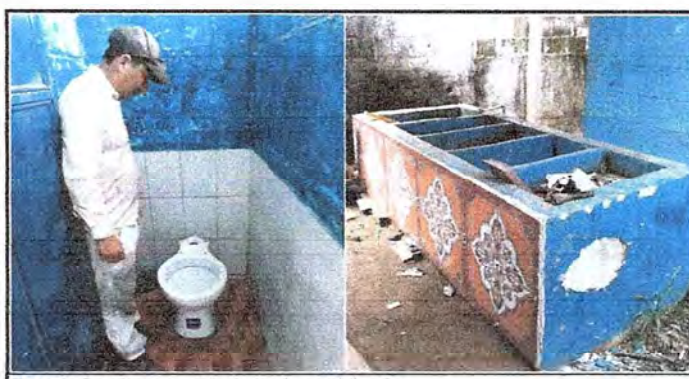
Foto 6: Se observa el trabajo de azulejeado
