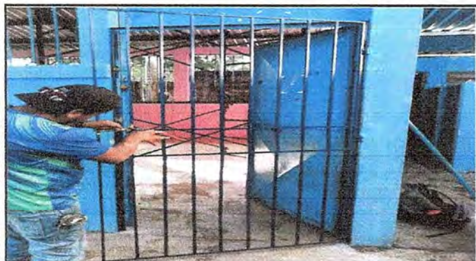
Foto 3: Se observa el trabajo en el cambio de puerta de reja de 1 x 2 metros
