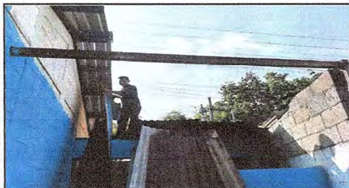
Foto 9: Se observa trabajo de desmontaje de techo de lámina en mal estado
