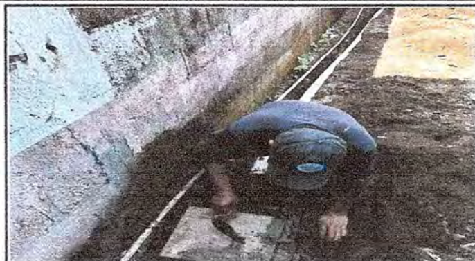
Foto 8: Se observa el trabajo de colocación dse caja de registro módulo 2
