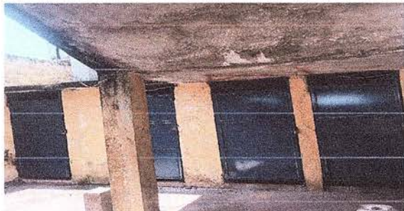
Foto 15: Colocación finalizada de puertas nuevas en los baños
