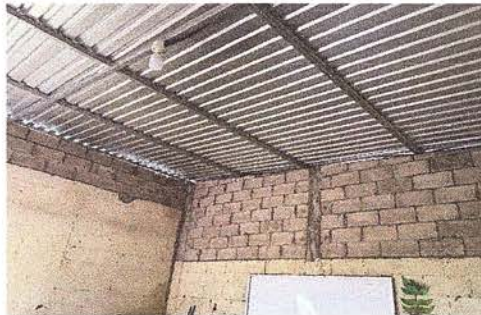
Foto 2: Estructura de metal que da soporte a las láminas finalizada
