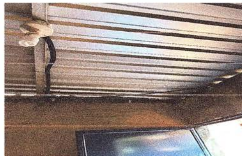
Foto 10: Sistema eléctrico nuevo en la bodega finalizado
