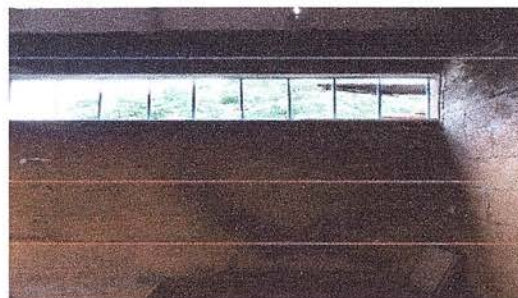
Foto 8: Ventana de ventilación en la cocina finalizada
