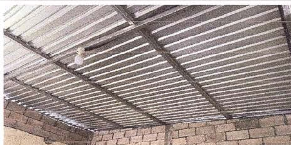
Foto 6: Sustitución finalizada de Estructura de metal que reemplaza la de madera
