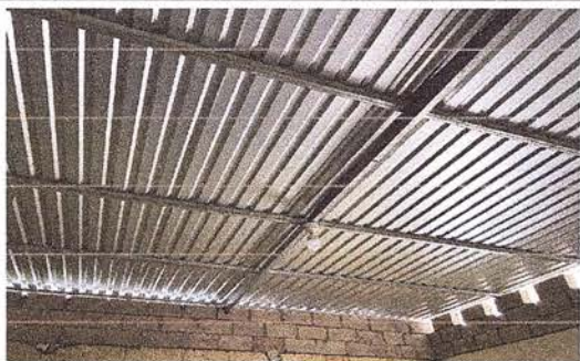
Foto 5: Sustitución completa del techo ya finalizada
