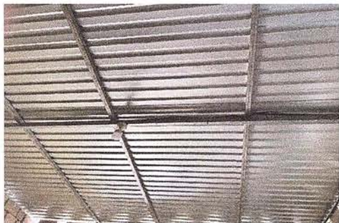
Foto 1: Techo finalizado con lámina troquelada aluzinc calibre 26
