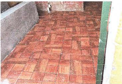
Foto 13: Colocación finalizada de piso antideslizante en la cocina
