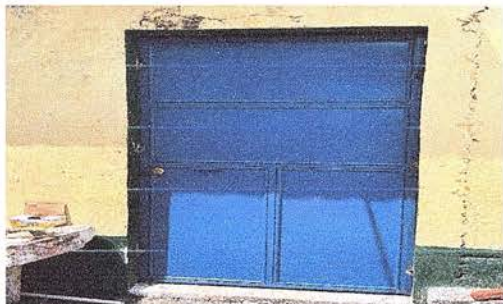
Foto 7: Puerta nueva de la bodega finalizada
