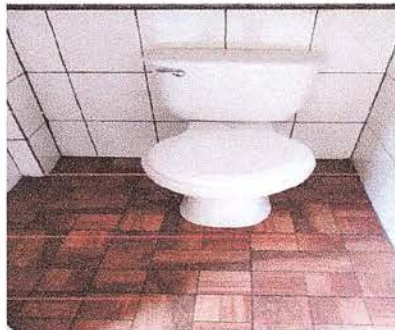
Foto 16: Remodelación finalizada de sanitario
