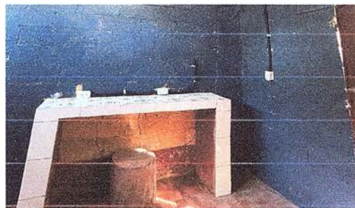
Foto 12: Mueble de cocina con azulejo instalado y finalizado
