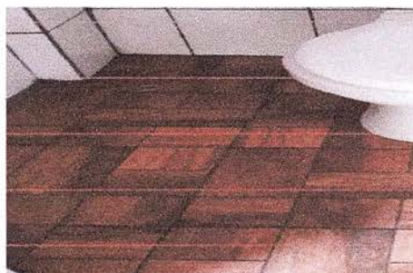
Foto 18: Instalación finalizada de piso antideslizante por seguridad de los niños.
