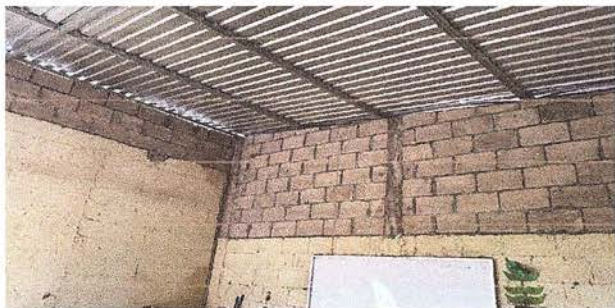
Foto 3: Hileras de blocks para levantar el techo ya finalizada
