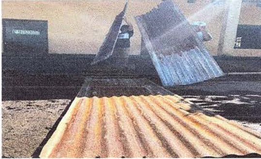
Foto 1: El techo se encuentra en proceso de cambio de lámina por lámina troquelada aluzinc calibre 26
