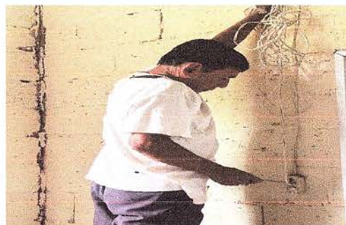
Foto 10: Sustitución de sistema eléctrico en cocina en proceso
