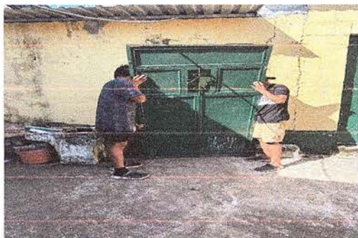
Foto 7: Puerta de módulo de bodega en proceso
