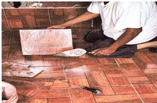
Foto 13: Área de cocina piso antideslizante en proceso
