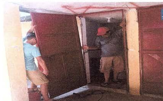
Foto 15: Sustitución de puertas en baños en proceso.
