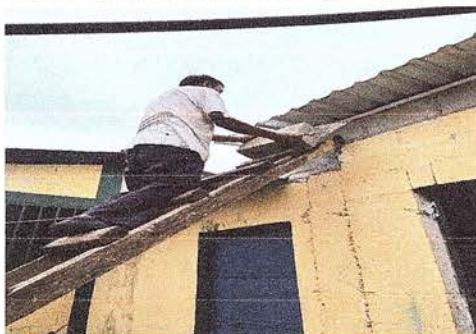
Foto 9: Es necesario subir el nivel del techo y conformación de muro en proceso
