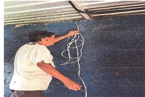
Foto 4: El sistema eléctrico en proceso de cambio
