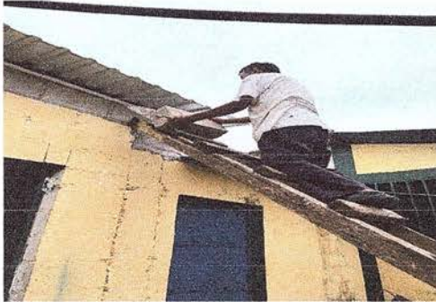
Foto 3: En proceso de aumento de altura de las aulas
