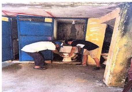
Foto 16: Cambio en proceso de los sanitarios.
