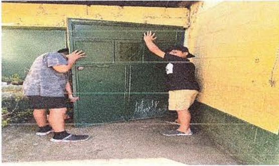
Foto 19: Puerta de metal en proceso de cambio en el módulo de aula.
