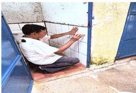
Foto 17: Proceso de colocación de azulejos.
