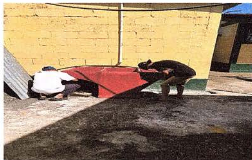
Foto 14: Pila en proceso de colocación.
