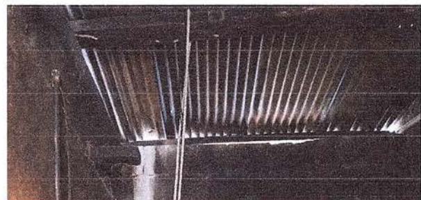
Foto 6: Sustitución de soporte de bodega en proceso
