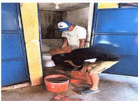
Foto 18: Proceso de colocación de piso antideslizante en el área del baño.
