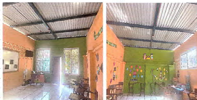
Foto 10: SE OBSERVA QUE LAS PAREDES DEL AULA SE ENCUENTRAN PINTADAS.
