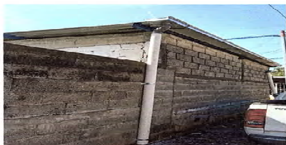
Foto7: SE OBSERVA QUE YA ESTÁ INSTALADO EL CANAL DE METAL Y BAJADA DE AGUA.
