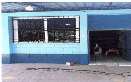
Foto 13: SE OBSERVA QUE SE ENCUENTRA INSTALADO BALCON Y VENTANA.
