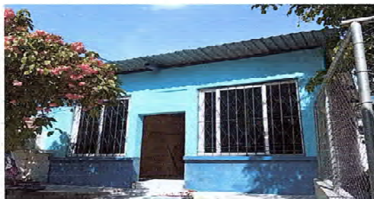
Foto 11: SE OBSERVA QUE EL AULA CUENTA CON MÁS ALTURA.
