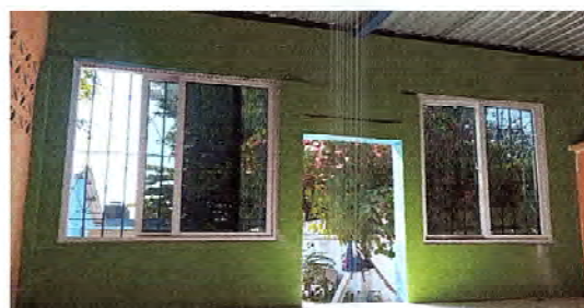
Foto 6: SE OBSERVA QUE LAS VENTANAS YA FUERON INSTALADAS.
