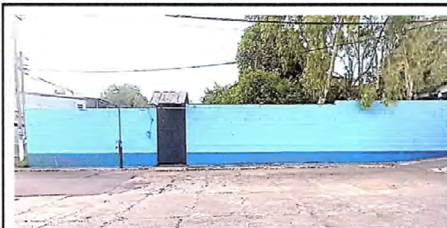
Foto 1: SE OBSERVA QUE LOS MUROS YA CUENTAN CON PINTURA..
