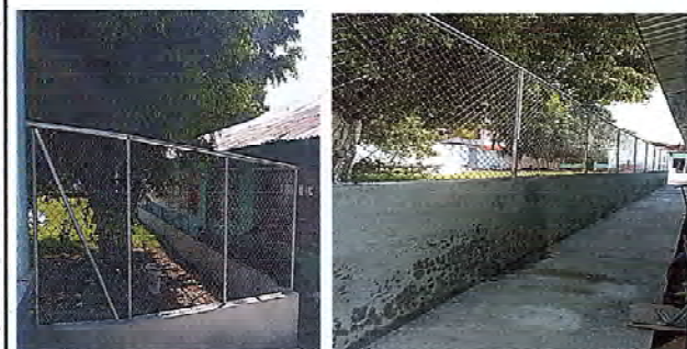
Foto 3: SE OBSERVA QUE YA SE CUENTA CON LA CERCA PERIMETRAL.
