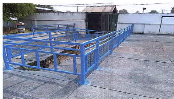
Foto 2: SE OBSERVA QUE YA ESTÁ INSTALADA LA BARANDA.
