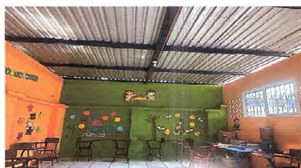
Foto 4: SE OBSERVA QUE LAS PAREDES YA CUENTA CON REPELLO Y GERNIDO.
