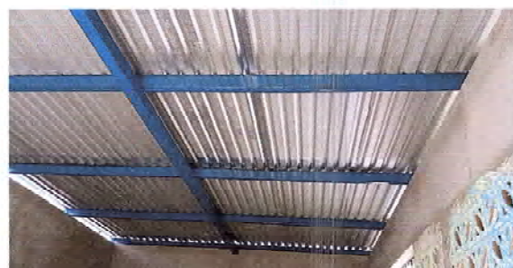
Foto 8: SE OBSERVA LA INSTALACIÓN DE LA NUEVA LÁMINA.
