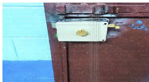
Foto 12: SE OBSERVA QUE ESTÁN TRABAJANDO EN EL CAMBIO DE CHAPA.
