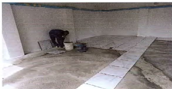
Foto 5: SE OBSERVA QUE ESTÁN TRABAJANDO EN LA INSTALACIÓN DE PISO GERÁMICO EN EL AULA.
