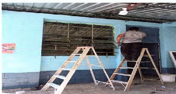
Foto 13: SE OBSERVA QUE ESTÁN TRABAJANDO EN EL CAMBIO DE VENTANA E INSTALACIÓN DE BALCÓN.
