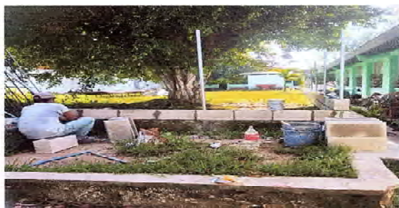
Foto 3: SE OBSERVA QUE ESTÁN TRABAJANDO EN LA INSTALACIÓN DE LA CERCA PERIMETRAL.
