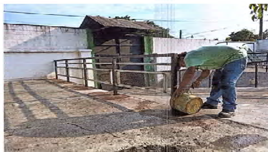
Foto 2: SE OBSERVA QUE ESTÁN TRABAJANDO EN LA INSTALACIÓN DE LA BARANDA POR EL PELIGRO EXISTENTE.
