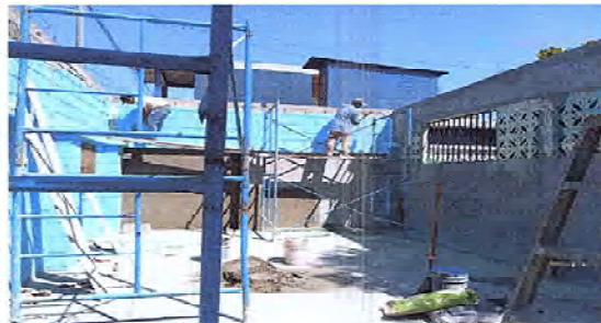
Foto 4: SE OBSERVA QUE ESTÁN REALIZANDO REPELLO EN MURO DE PAREDES.
