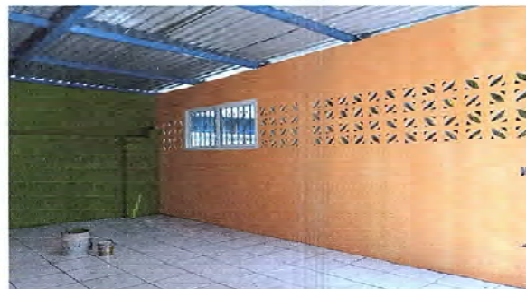
Foto 10: SE OBSERVA QUE ESTÁN PINTANDO LAS PAREDES DEL AULA.
