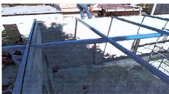
Foto 7: SE OBSERVA QUE ESTÁN TRABAJANDO EN LA INSTALACIÓN DE CANAL.
