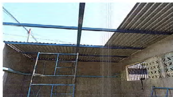
Foto 8: SE OBSERVA QUE ESTÁN TRABAJANDO EN LA INSTALACIÓN DE LÁMINA.
