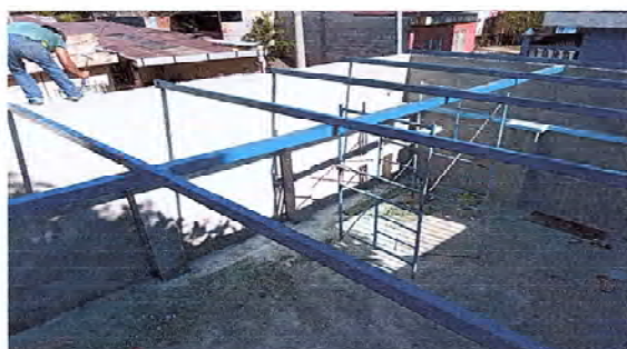
Foto 9: SE OBSERVA QUE SE DESINSTALÓ LA RED ELÉCTRICA PARA REALIZAR EL CAMBIO.
