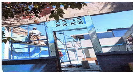
Foto 11: SE OBSERVA QUE ESTÁN SUBIENDO HILADAS DE BLOCK PARA QUE TENGA MÁS ALTURA.
