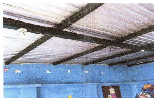
Foto 4: SE OBSERVA QUE SE NECESITA REPELLO EN MURO DE PAREDES.
