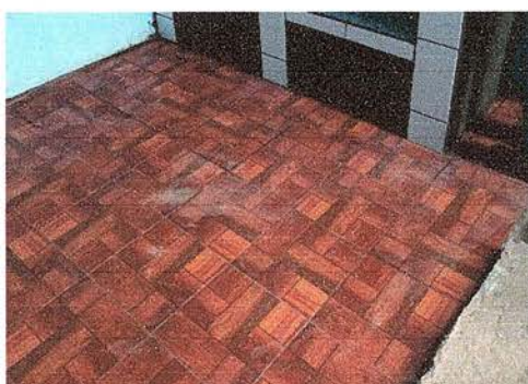
Foto 4: Sustitución completo del piso antideslizante, debido a que el piso de cemento estaba deteriorado
