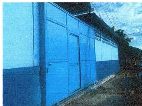
Foto 8: Se observa el portón instalado estilo corredizo
