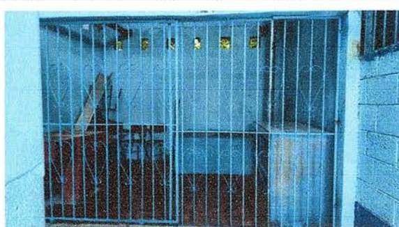
Foto 6: Se muestra la reja que se instaló en la cocina
