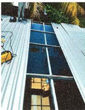
Foto 3: Se observa la colocación final de estructura de metal
