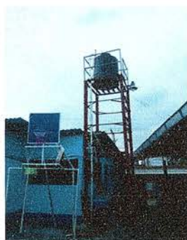
Foto 11: Se observa el pozo en funcionamiento
