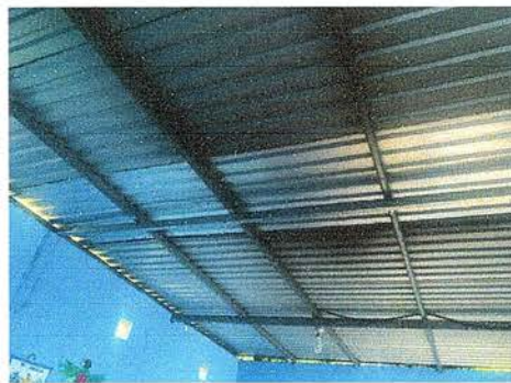
Foto 2: Se observa la colocación de la lamina troquelada por la que estaba dañada
