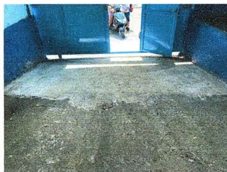
Foto 10: Se observa la plancha de concreto terminada.
