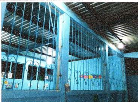
Foto 9: Se observa los balcones instalados
