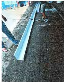
Foto 1: Se observa el proceso de colocación de canal para desfogar el agua pluvial(bajadas de agua) para que ya no inunde el acceso al establecimiento
