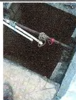
Foto 12: Se observa el proceso de instalación de la bomba de agua en el pozo
