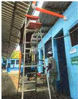
Foto 1: Se observa el proceso de colocación de canal para desfogar el agua pluvial(bajadas de agua) para que ya no inunde el acceso al establecimiento
