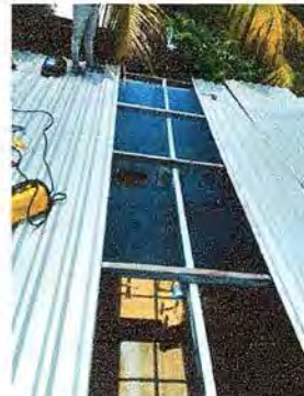
Foto 2: Se observa la colocación de la lamina troquelada por la que estaba dañada
