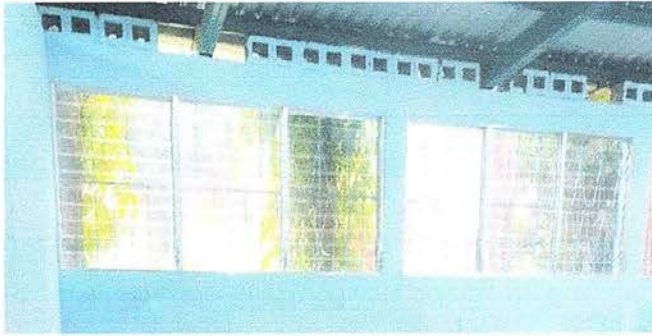
Foto 1: SE OBSERVA QUE COLOCARON VENTANAS EN LAS AULAS.
