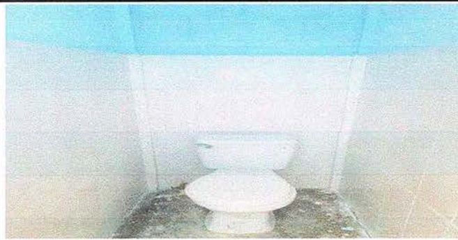
Foto 9: SE OBSERVA QUE SE COLOCO AZULEJO EN LOS BAÑOS
