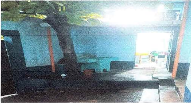
Foto 7: SE OBSERVA QUE SE INSTALO LÁMINA Y ESTRUCTURA DE METAL, PILA Y CONFORMACIÓN DE UNA HILERA DE BLOCK SOBRE LA LOSA
