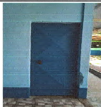
Foto 2: Se observa la finalización de la puerta
