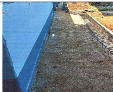
Foto 4: Se observa la finalización de torta de concreto
