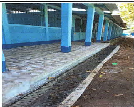
Foto 9: Se observa la finalización de la cuneta con parrilla de metal
