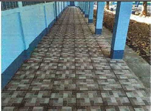
Foto 1: Se observa la finalización del piso cerámico
