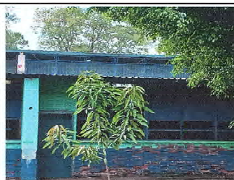
Foto 12: Se observa la finalización de la estructura
