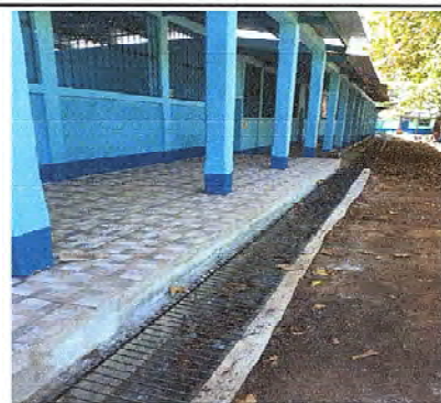
Foto 8: Se observa la finalización de la cuneta
