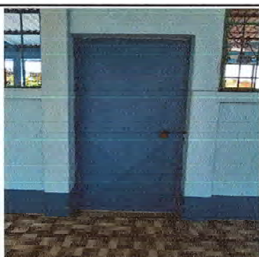
Foto 3: Se observa la finalización de la puerta
