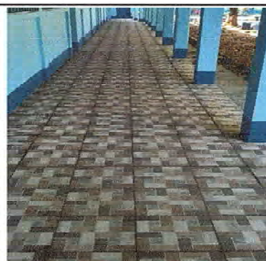
Foto 10: Se observa la finalización de la pintura
