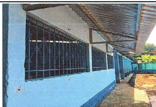
Foto 6: Se observa la finalización de estructura
