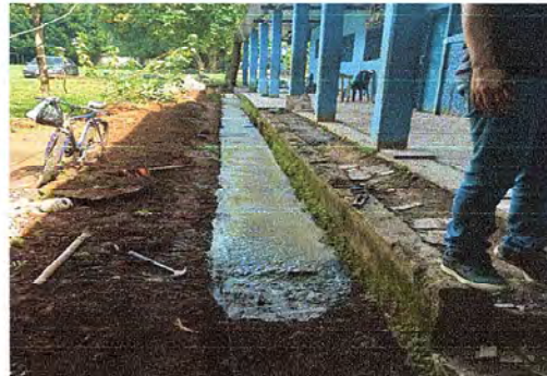
Foto 8: Se observa el proceso de la cuneta
