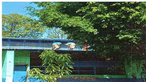
Foto 12: Se observa el proceso de reforzamiento
