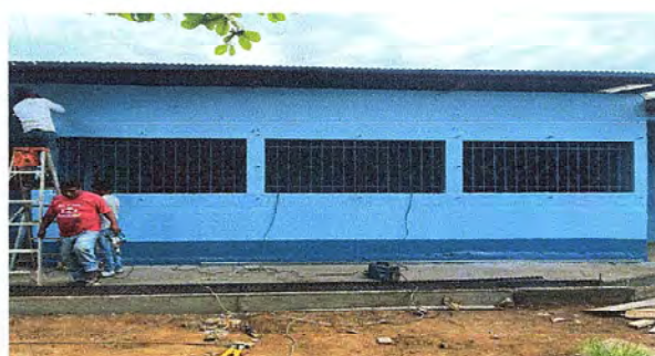
Foto 6: Se observa el proceso de estructura
