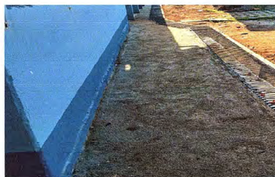
Foto 4: Se observa el proceso de la torta de concreto para la unión de las aulas
