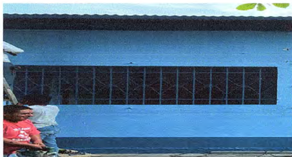
Foto 5: Se observa el proceso de instalación de los balcones
