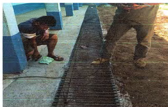
Foto 9: Se observa el proceso de la cuneta y parrilla de metal
