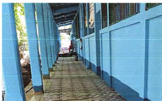
Foto 10: Se observa el proceso de la pintura
