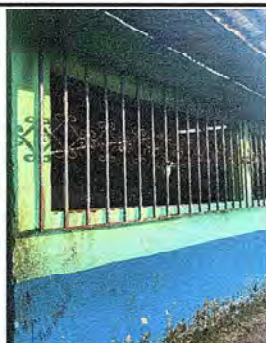
Foto 5: Se observa el deterioro del balcón y cuenta con dobleces y cortes por abrirlos a la fuerza
