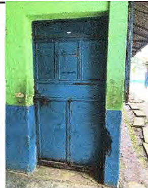
Foto 2: Se observa el deterioro de la puerta y chapa va no cierra y cuenta con dobleces
