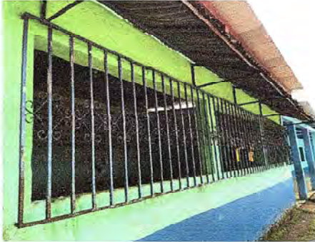
Foto 7: Se observa el mal estado de la lamina y mal sujeta
