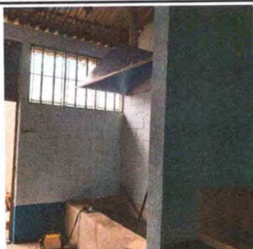
FOTO 2.7: SE REPARÓ LA PARED
