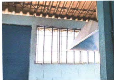
FOTO 2.6: SE SUSTITUYO LA MALLA DE LA VENTANA
