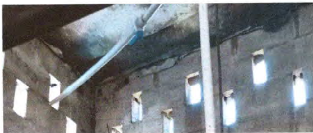
FOTO 1.5: SE REPARO LA LÍNEA PRINCIPAL
