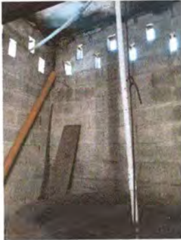
FOTO 1.7: SE REPARÓ LA BOMBA DE AGUA.
