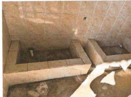
FOTO 1.2 SE REPARÓ AMBOS MINGITORIOS
