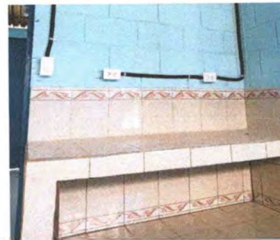
FOTO 2.2: SE SUSTITUYÓ EL BANCO DE TRABAJO
