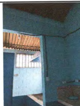
FOTO 2.8: SE OBSERVA QUE LAS PAREDES FUERON PINTADAS.
