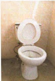
FOTO 1.1 SE OBSERVA QUE SE REPARÓ EL INODORO
