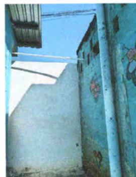
FOTO 1.4: SE REPARÓ EL MURO PARA MEJORAR LA COCINA Y COLOCAR LA CAMPANA
