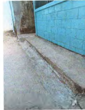
FOTO 1.8: SE OBSERVA LA REPARACIÓN DE LA LÍNEA PRINCIPAL.
