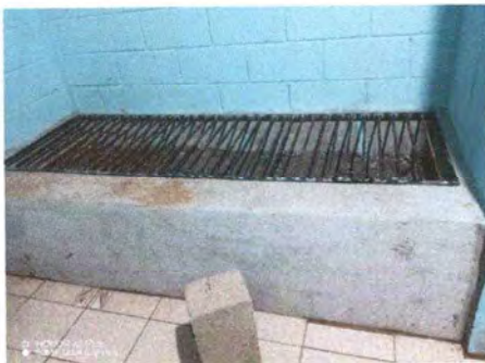
FOTO 2.1: SE REPARÓ LA ESTUFA RURAL
