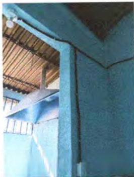
FOTO 2.5: SE SUSTITUYÓ EL SISTEMA ELÉCTRICO
