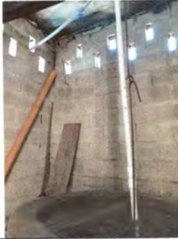
FOTO 1.7: SE INICIARON LOS TRABAJOS DE REPARACIÓN DE LA BOMBA DE AGUA.
