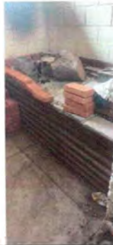
FOTO 2.1: SE INICIÓ CON LA SUSTITUCIÓN DE LA ESTUFA RURAL
