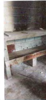
FOTO 2.2: SE INICIARON LOS TRABAJOS PARA LA SUSTITUCIÓN DE BANCO DE TRABAJO.
