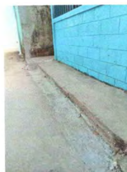
FOTO 1.4: SE INICIÓ CON LA REPARACIÓN DEL MURO
