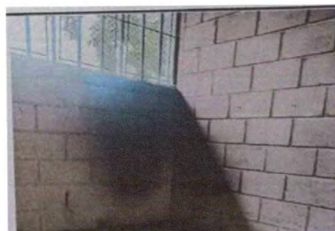
FOTO 2.8: AUN NO SE HA INICIADO CON LA APLICACIÓN DE PINTURA.
