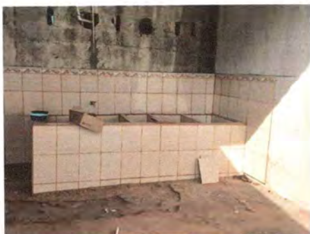
FOTO 2.9: SE ESTÁ TRABAJANDO EN LA COLOCACIÓN DE AZULEJO EN LA PILA DE CONCRETO Y MURO DE PILA.
