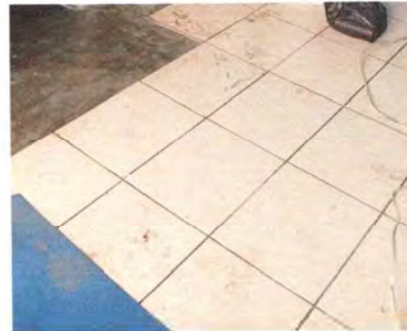
FOTO 2.4: SE INICIÓ CON LA REPARACIÓN DEL PISO DE CEMENTO Y COLOCACIÓN DE PISO CERÁMICO.
