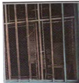
FOTO 2.6: AUN NO SE INICIA CON EL TRABAJO DE SUSTITUCIÓN DE MALLA METÁLICA
