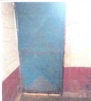
FOTO2.3: SE OBSERVA MANTENIMIENTO DE PUERTA DE METAL
