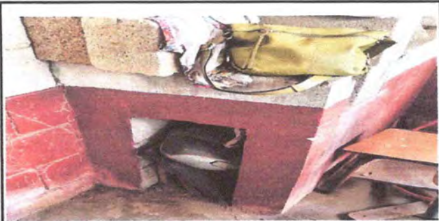
FOTO2.2: SE OBSERVA SUSTITUCION DE BANCO DE TRABAJO DE CONCRETO
