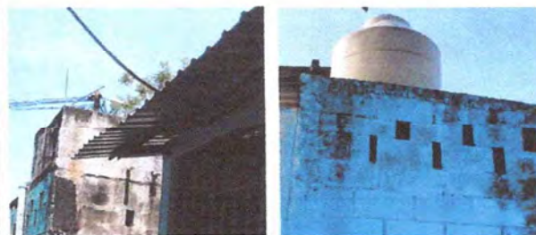
FOTO1.6: SE OBSERVA SUMINISTRO E INSTALACION DE DEPOSITO AGUA
