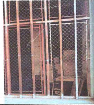
FOTO2.6: SE OBSERVA SUSTITUCION DE MALLA METALICA EN VENTANA
