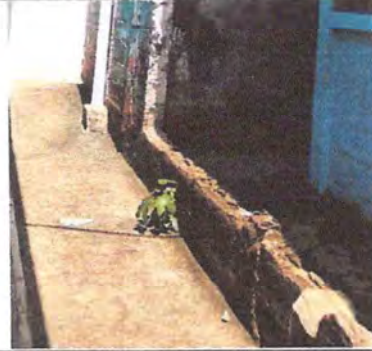
FOTO1.8 : SE OBSERVA REPARACION DE LINEA PRINCIPAL
