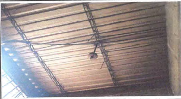
FOTO2.5: SE OBSERVA SUSTITUCION DE SISTEMA ELECTRICO
