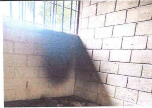
FOTO2.8: SE OBSERVA RESANE Y APLICACIÓN DE PINTURA LATEX ACRILICA
