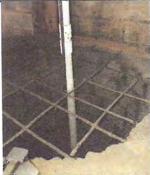
FOTO1.7: SE OBSERVA REPARACION DE BOMBA DE AGUA
