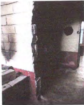
FOTO2.7: SE OBSERVA REPARACION DE PARED
