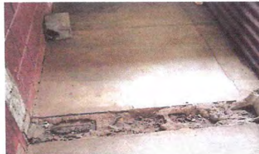
FOTO2.4: SE OBSERVA REPARACION DE PISO CEMENTO LIQUIDO
