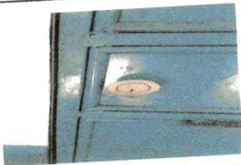
Foto 5: Se observa la necesidad de cambio de chapa debido a que las se encuentran actualmente no tienen llave para poder asegurar las puertas.
