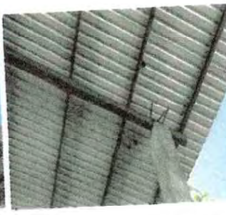
Foto 9: Se Observa la necesidad de darle mantenimiento a la estructura de metal de la cancha deportiva, porque desde su construcción no se ha hecho un mantenimiento adecuado y los signos de corrosión son evidentes.
