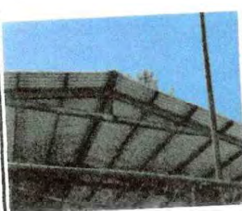
Foto 9: Se Observa la necesidad de darle mantenimiento a la estructura de metal de la cancha deportiva, porque desde su construcción no se ha hecho un mantenimiento adecuado y los signos de corrosión son evidentes.
