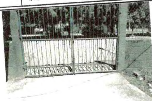
Foto 2: Se observa la necesidad de darle mantenimiento al poton para evitar corrosión y soldar algunas varillas que se han soltado.
