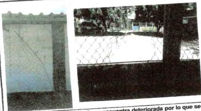
Foto 2: Se observa la necesidad de darle mantenimiento al poton para evitar corrosión y soldar algunas varillas que se han soltado.
