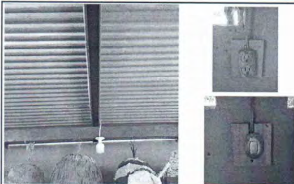
Foto 7: Se observa el sistema eléctrico en mal estado, urge sustituirlo
