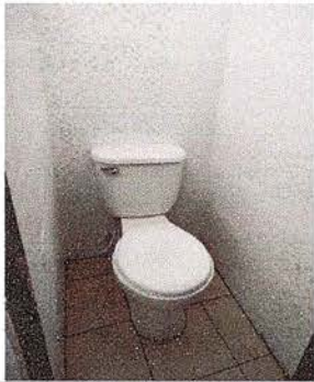
FOTO 7: SE OBSERVA LA FINALIZACIÓN DE COLOCACIÓN DE PISO ANTIDESLIZANTE Y AZULEJO EN PAREDES.
