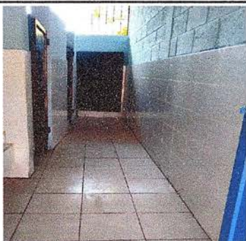
FOTO 3: SE OBSERVA LA FINALIZACIÓN DE PEGADO DEL AZULEJO EN SERVICIOS SANITARIOS, DEBIDO QUE HUBO CAMBIO DE RENGLÓN SEGÚN CONSTA EN EL ACTA NO. 12-2024.
