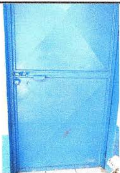
FOTO 13: SE OBSERVA LA FINALIZACIÓN DEL MANTENIMIENTO DE PUERTAS.
