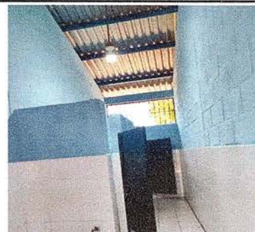
FOTO 12: SE OBSERVA LA FINALIZACIÓN DE PINTADO DE PAREDES.
