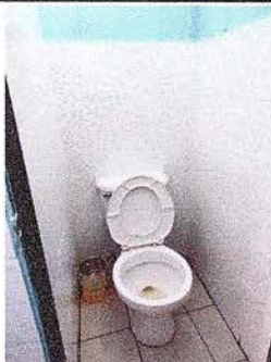
FOTO 11: SE OBSERVA LA FINALIZACIÓN DE CAMBIO DE BAÑO, PISO ANTIDESLIZANTE Y AZULEJO.
