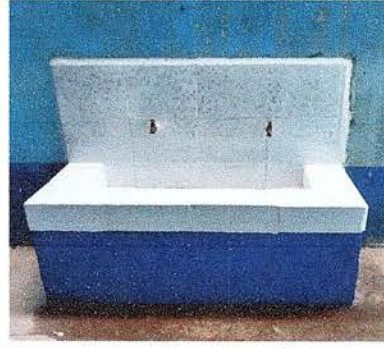
FOTO 8: SE OBSERVA LA FINALIZACIÓN DE CAMBIO DE CHORROS.
