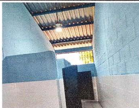
FOTO 14: SE OBSERVA LA FINALIZACIÓN DE ARREGLO DEL SISTEMA ELÉCTRICO.
