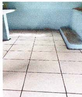
FOTO 4: SE OBSERVA LA FINALIZACIÓN DE CAMBIO DEL PISO RÚSTICO A PISO ANTIDESLIZANTE.
