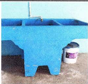
FOTO 17: SE OBSERVA LA FINALIZACIÓN DE CAMBIO DE PILA.
