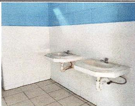
FOTO 15: SE OBSERVA LA FINALIZACIÓN DEL SISTEMA DE MANECILLAS Y MANGUERAS.
