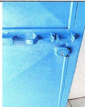
FOTO 16: SE OBSERVA LA FINALIZACIÓN DE CAMBIO DE CHAPA DE LA PUERTA.
