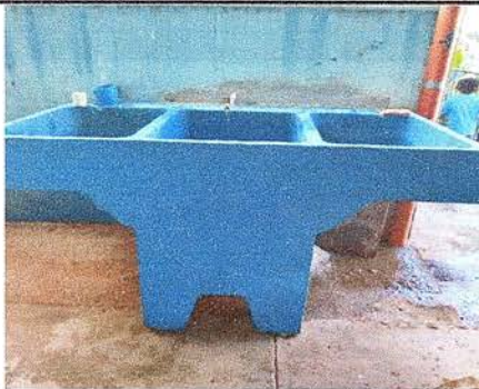
FOTO 9: SE OBSERVA LA FINALIZACIÓN DE LA COLOCACIÓN DE LA PILA.
