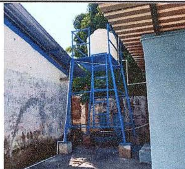
FOTO 10: SE OBSERVA LA FINALIZACIÓN DE LA ELABORACIÓN DE LA BASE DEL ROTOPLAS Y SU TUBERÍA.
