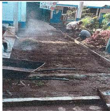
FOTO 2: SE OBSERVA EL PROCESO DE LA PLANCHA DE CONCRETO AL AL INGRESAR DEL CENTRO EDUCATIVO.
