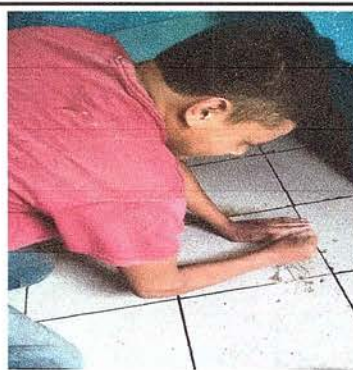
FOTO 4: SE OBSERVA EL PROCESO DE CAMBIO DEL PISO RÚSTICO A PISO ANTIDESLIZANTE.
