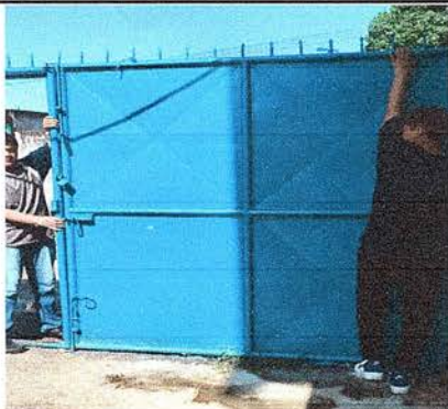
FOTO 1: SE OBSERVA EL PROCESO DE CAMBIO DEL PORTÓN DE INGRESO AL CENTRO EDUCATIVO.
