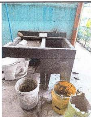
FOTO 9: SE OBSERVA EL PROCESO DE LA COLOCACIÓN DE LA PILA.
