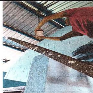
FOTO 14: SE OBSERVA EL PROCESO DE ARREGLO DEL SISTEMA ELÉCTRICO.
