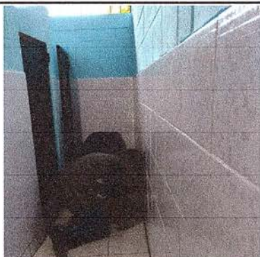
FOTO 3: SE OBSERVA EL PROCESO DE PEGADO DEL AZULEJO EN SERVICIOS SANITARIOS, DEBIDO QUE HUBO CAMBIO DE RENGLÓN SEGÚN CONSTA EN EL ACTA NO. 12-2024.
