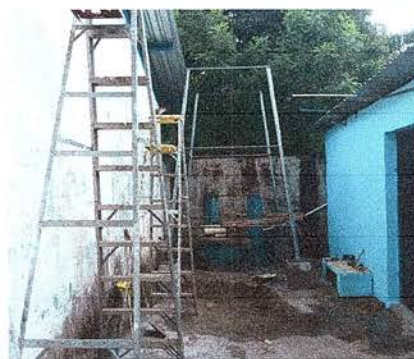
FOTO 10: SE OBSERVA EL PROCESO DE LA ELABORACIÓN DE LA BASE DEL ROTOPLAS Y SU TUBERÍA.
