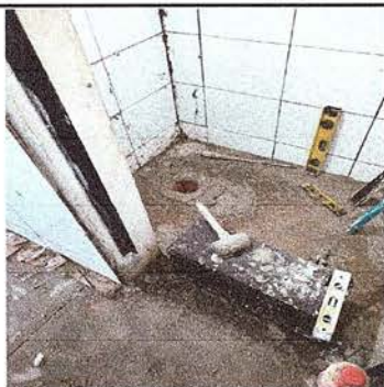
FOTO 11: SE OBSERVA EL PROCESO DE CAMBIO DE BAÑO, PISO ANTIDESLIZANTE Y AZULEJO.
