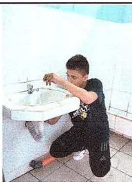
FOTO 15: SE OBSERVA EL PROCESO DEL SISTEMA DE MANECILLAS Y MANGUERAS.
