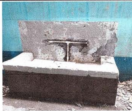
FOTO 8: SE OBSERVA EL PROCESO DE CAMBIO DE CHORROS.
