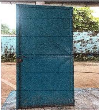
FOTO 13: SE OBSERVA EL PROCESO DEL MANTENIMIENTO DE PUERTAS.
