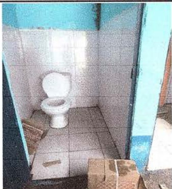
FOTO 7: SE OBSERVA EL PROCESO DE COLOCACIÓN DE PISO ANTIDESLIZANTE Y AZULEJO EN PAREDES.
